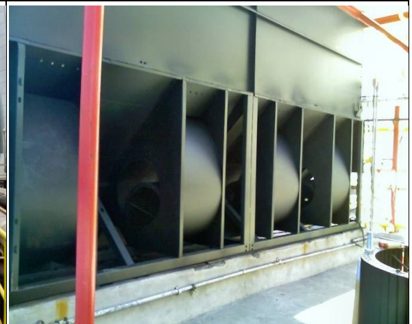
Condens. VLC-500 com tinta epóxi aplicada interna e externamente, antes da aplicação da tinta alumínio.
