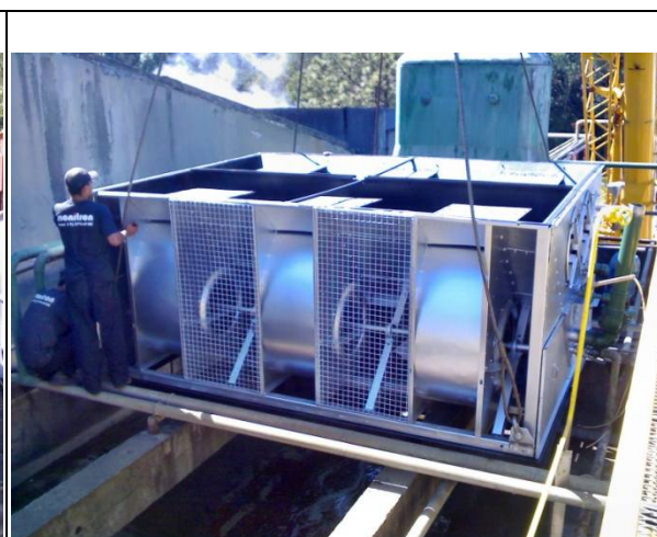
Módulo após reforma sendo recolocado na base.
